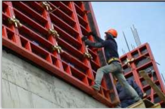
Монтаж и демонтаж опалубки монолитных железобетонных конструкций
