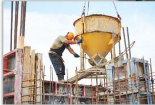
Бетонирование по схеме "кран-бадья"
